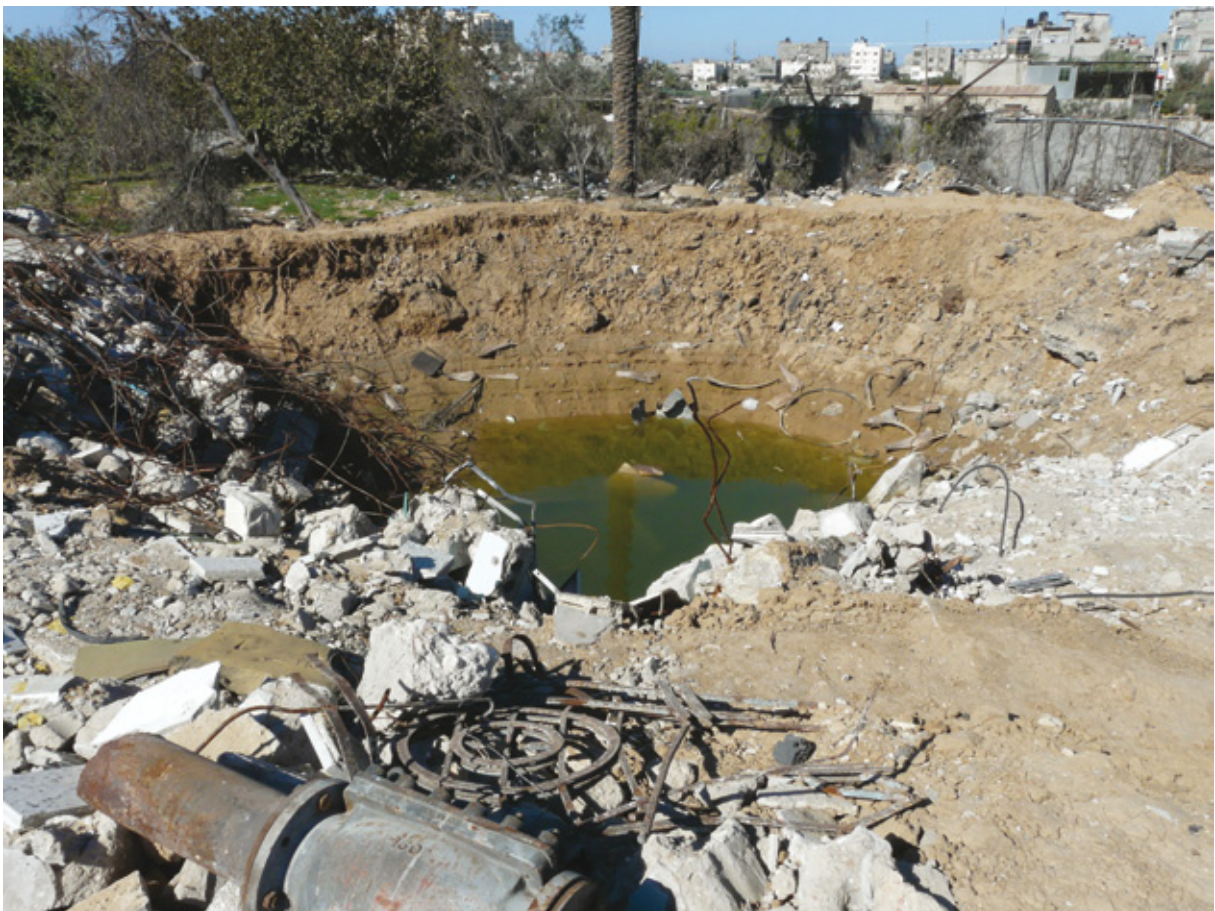
Während der Operation "Gegossenes Blei" im Dezember 2008/Januar 2009 zerstörten israelische Luftangriffe Kanalisationsrohre im nördlichen Gazastreifen und hinterließen freiliegende Schmutzwasserteiche – © AI
